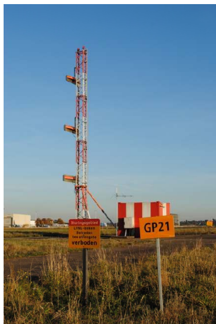
Afbeelding: Glidepath antenne baan 21
